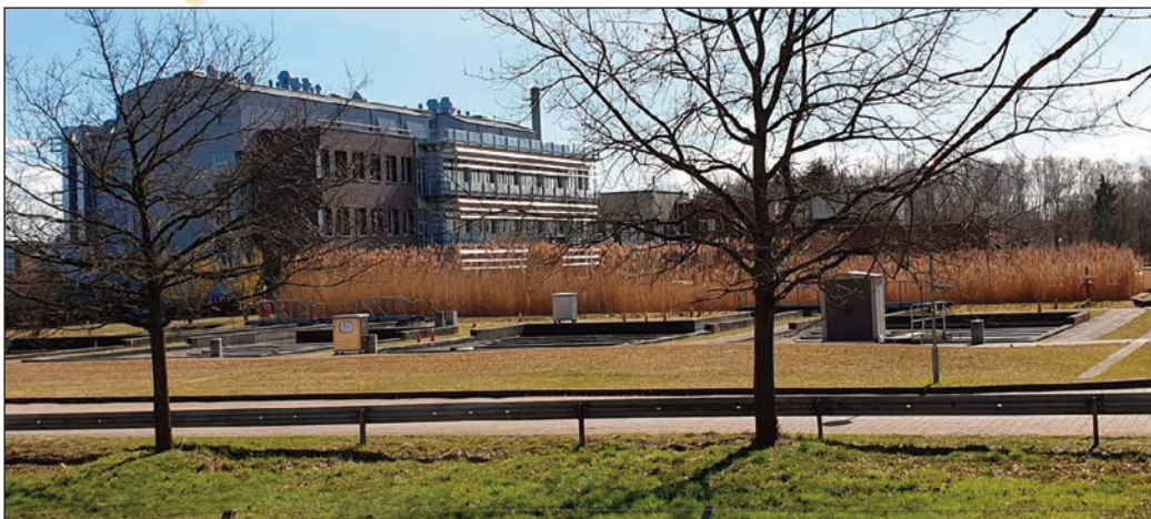
Fließ- und Stillwasser-Simulationsanlage des Umweltbundesamtes auf dem Nachbargelände
