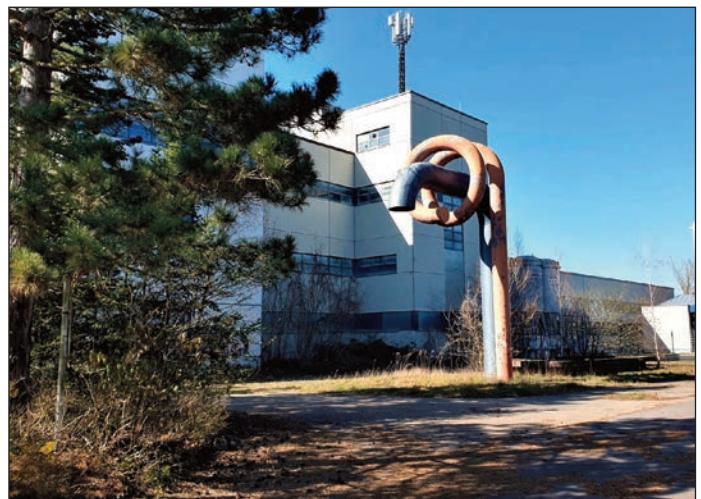
Heutiger Zustand des ehemaligen Klärwerkes, Außenansicht.
